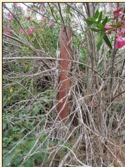
שניים מהצינורות לאורך קו המים ברחוב התמר, המכונים 'נשמים', צילם גונן ישר, 2026
