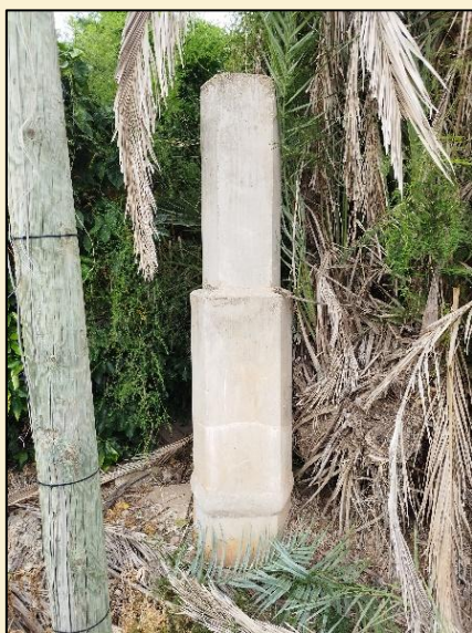
שניים מהצינורות לאורך קו המים ברחוב התמר, המכונים 'נשמים', צילם גונן ישר, 2026
